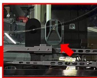
■ガラス面下部貼付け
